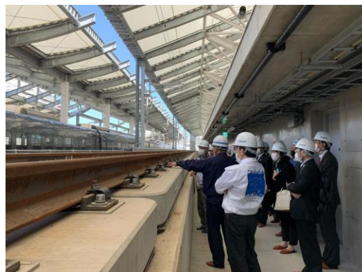
長崎駅舎の様子
