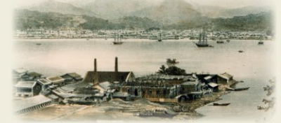
1860年頃の建設中の長崎製鉄所。レンガ造りの鍛冶場など3つの工場を備えて完成。現在の三菱重工長崎造船所のルーツとなりました(三菱重工(株)長崎造船所提供)
